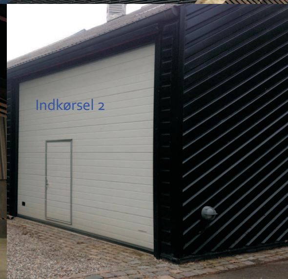
Bemærk betonarmerede vægge
